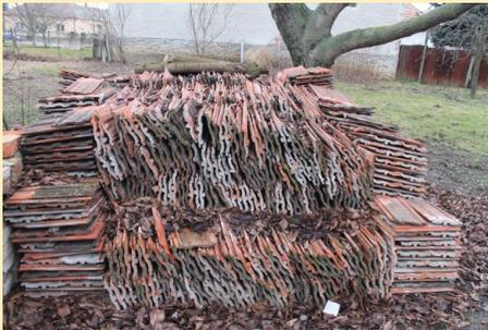
**Dachziegel:** falls sie nicht zerbröckelt sind, können sie prinzipiell wiederverwendet werden (z.B. bei Renovierungsarbeiten), da sie zerstörungsfrei rückgebaut werden können.
