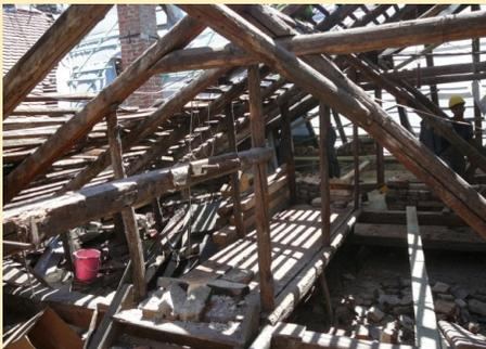
Bedachung, **Dachsparren** sind meistens nicht wiederverwendbar, oft werden diese Teile von Pilzen oder Insekten angegriffen, so müssen diese Bauteile vor einer Wiederverwendung gründlich untersucht werden.
